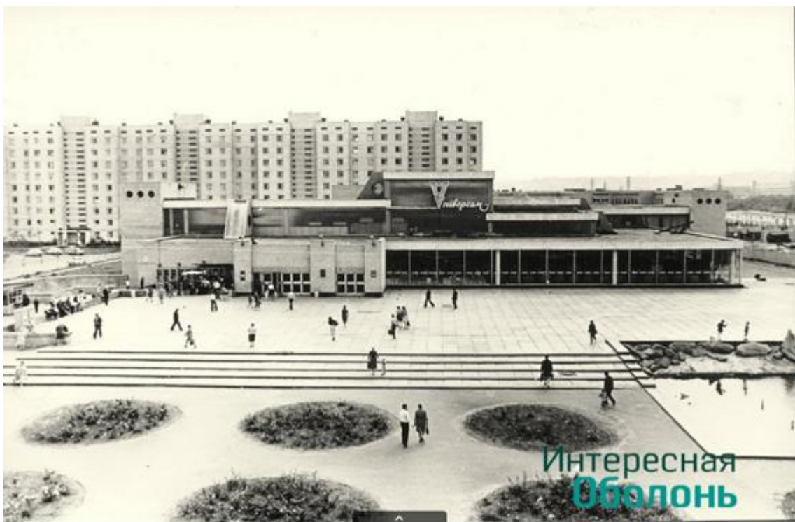
Habitatges i centre de districte a Obolon
